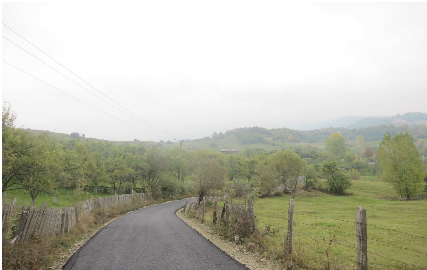
Drumul Comunal D.C 4 Spinu-Podeni – construit în anul 2014, deservește satul Podeni.
